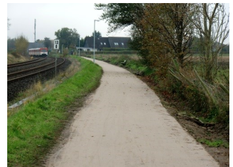
Begonnene Instandsetzung des Lerchenwegs
